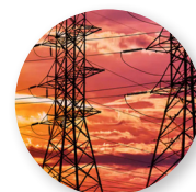
Test rete elettrica
